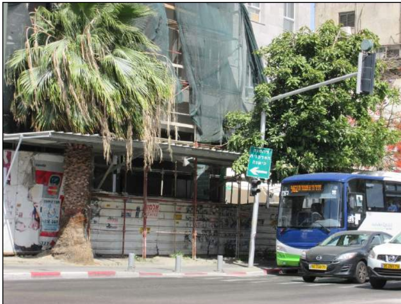
איור 15 - מפגש פיגומים ועצים ברחוב
