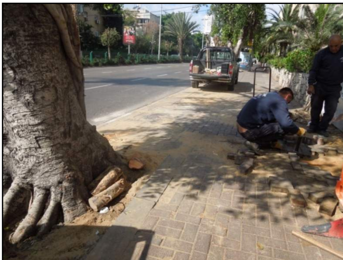
איור 16- ימין: חפירת בור וקידוח אופקי בסמוך לעץ; שמאל: חיתוך שורשים שחדרו לבניין סמוך ושיפוץ המדרכה
